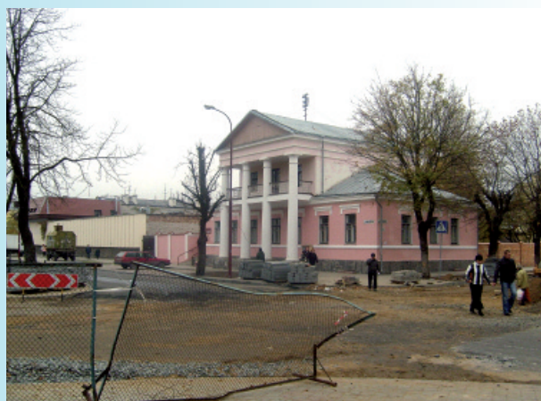
Wszędzie trwają prace remontowe
