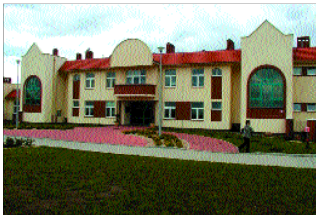
Ryc. 1. Budynek Ośrodka Szkolno-Wychowawczego im. Marii Grzegorzewskiej we Wrocławiu.
